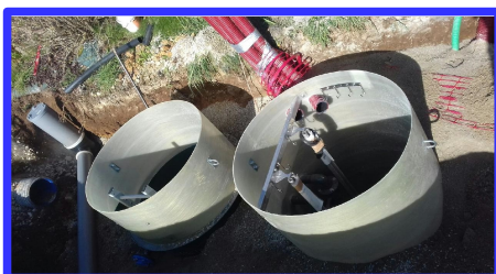
A gauche : dispositifs de pompages. A droite : aspirateur-tranchée ouverte.
